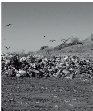
Fotos 4 e 5 – Imagens obtidas durante a ação fiscalizatória, demonstrando ausência de cobertura de resíduos em aterro e o descarte irregular de resíduos volumosos e de construção civil. | Fonte: Painel Fiscalizações Ordenadas (TCESP, 2023)
