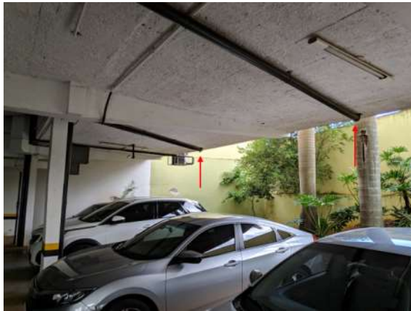
Foto 20 – Foto ilustrativa da tubulação existente a ser ligada com a calha
