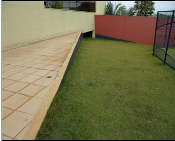
Foto 17 – Foto ilustrativa do local onde será executado a canaleta
