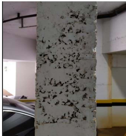
Foto 02 – Foto ilustrativa de elemento estrutural a ser tratado
