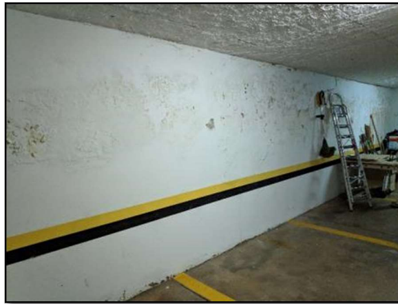
Foto 25 – Foto ilustrativa das paredes que receberão impermeabilização bicomponente
