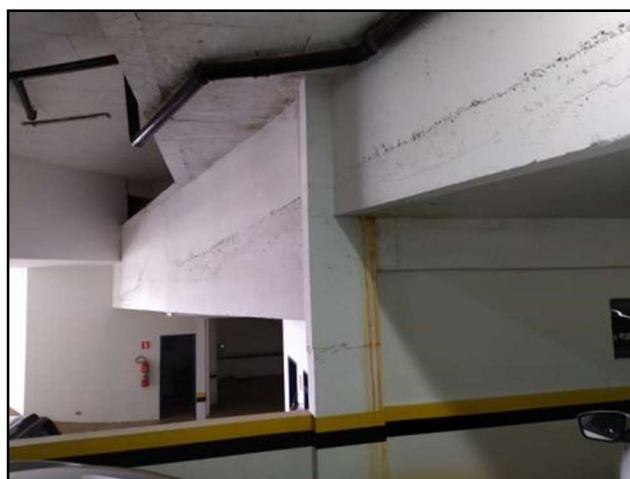
Foto 05 – Foto ilustrativa de elemento estrutural a ser tratado
