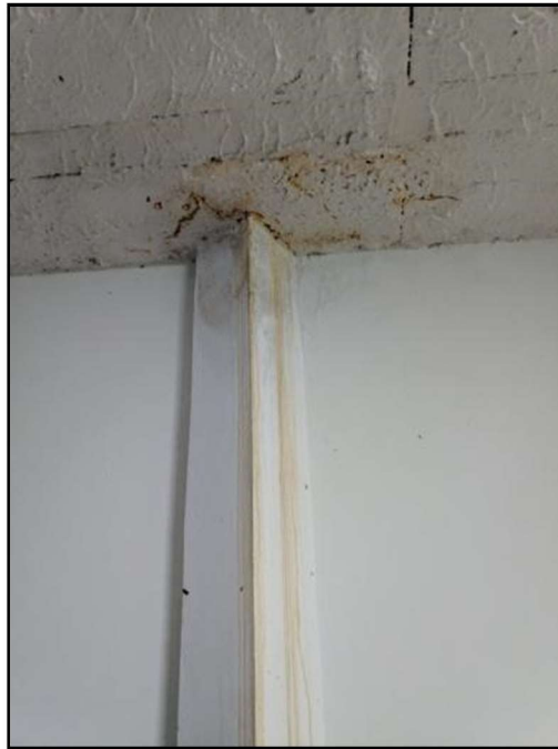
Foto 03 – Foto ilustrativa de elemento estrutural a ser tratado
