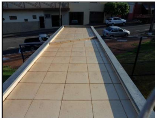
Foto 09– Foto ilustrativa do local onde será instalada a barreira de alvenaria sobre laje do túnel
