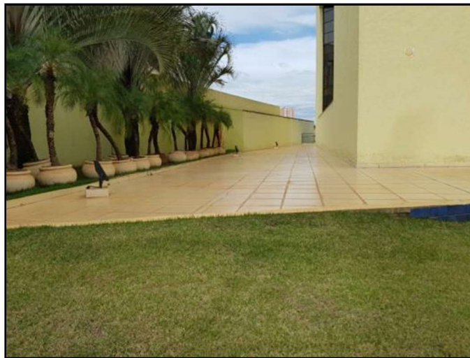
Foto 18 – Foto ilustrativa do local onde será executado a canaleta
