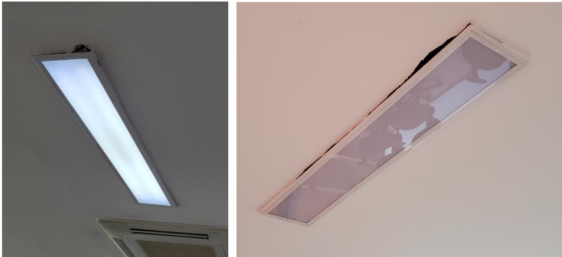
Imagens 12 e 13 – Interface na qual deverá ser realizada a aplicação de selante.
