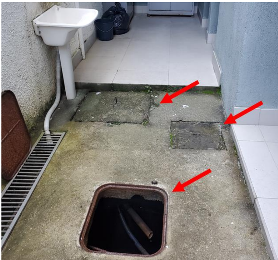
Imagem 2 – Caixa da minielevatória a ser substituída (seta superior), caixa de passagem a ser mantida (seta intermediária) e caixa de elevação de água pluvial a ser limpa (seta inferior).
