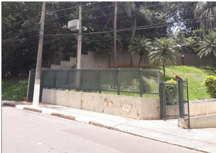
Foto 14 – Portão metálico de divisa.
