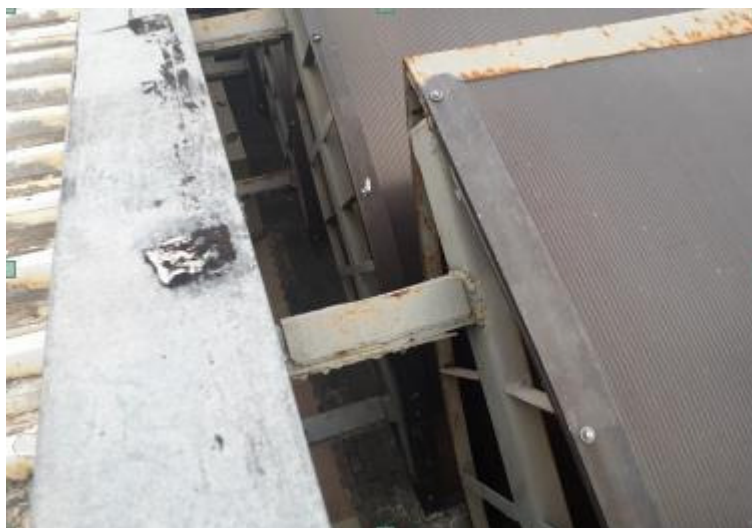
Foto 8 – Fixação da “cinta” de alumínio para encaixe do policarbonato.
