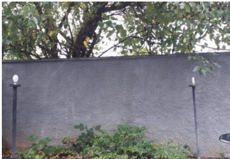
Foto 13 – Muro de divisa – cor cinza.
