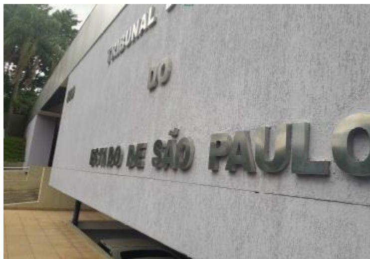
Foto 10 – Fachada principal – cor “roxa”.
