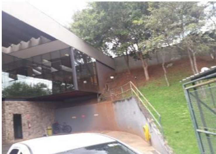
Foto 4 – Mureta a ser acrescida altura.
