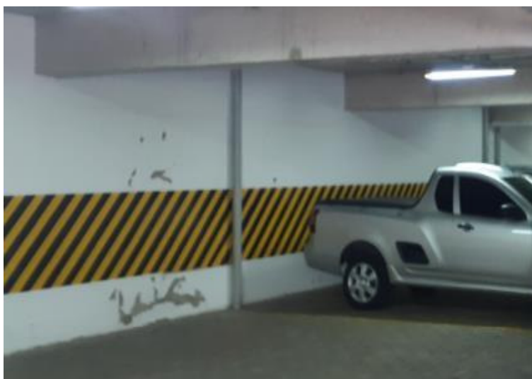
Foto 5 – Infiltração junto à parede externa da tubulação.
