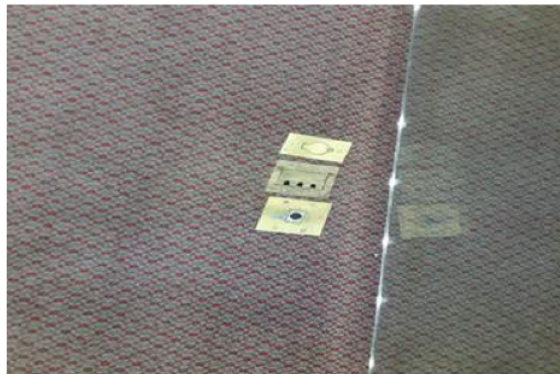
Imagem 9 - Insetção dos espelhos para tomadas.
