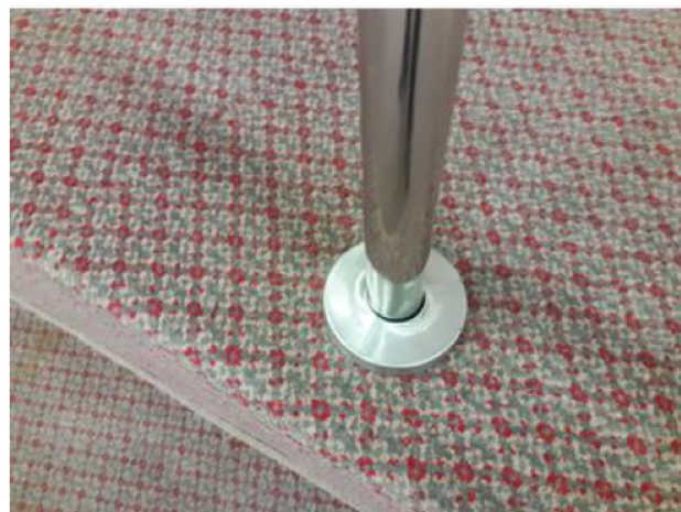
Imagem 12 – Suporte de fixação do corrimão.
