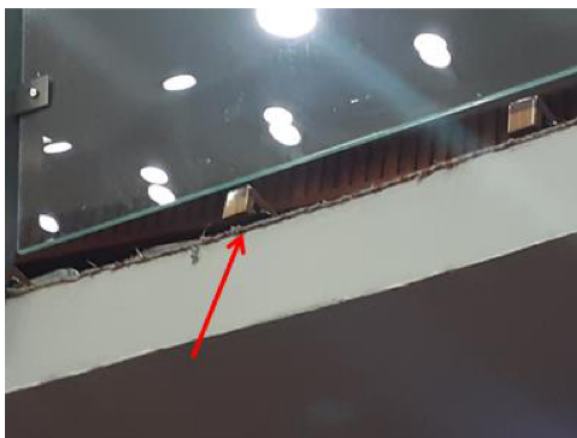
Imagem 10 – Local a ser considerado acabamento ou arremate com mata-junta.
