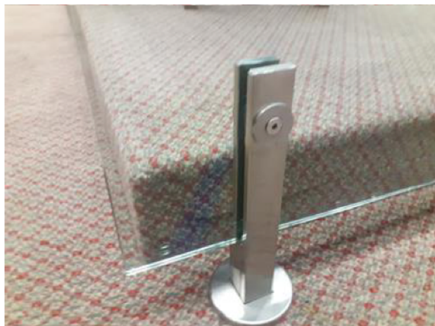
Imagem 11 – Suporte de fixação do guarda-corpo.
