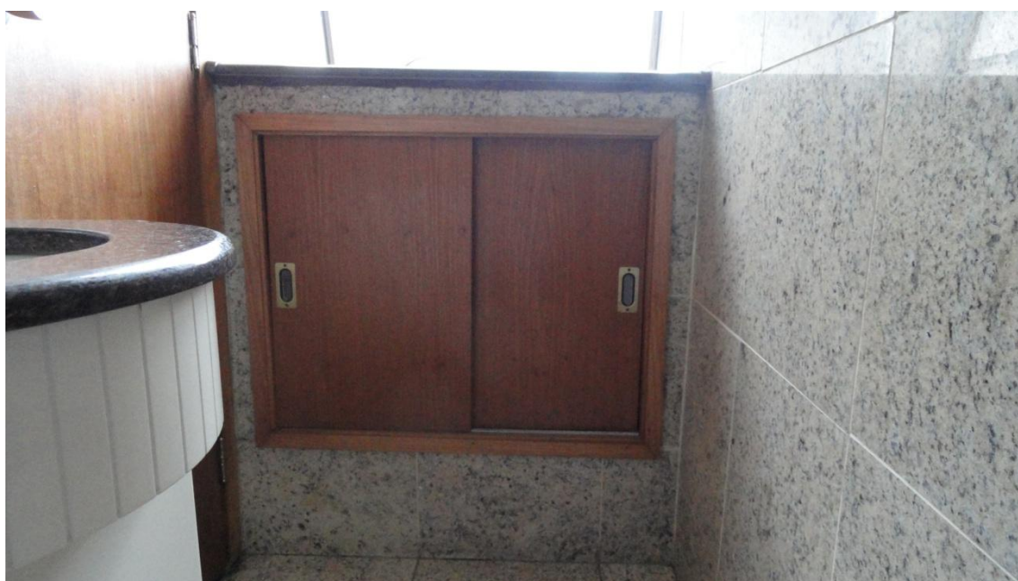
Foto 02 – Requadro com 02 portas de correr no balcão dos banheiros;
