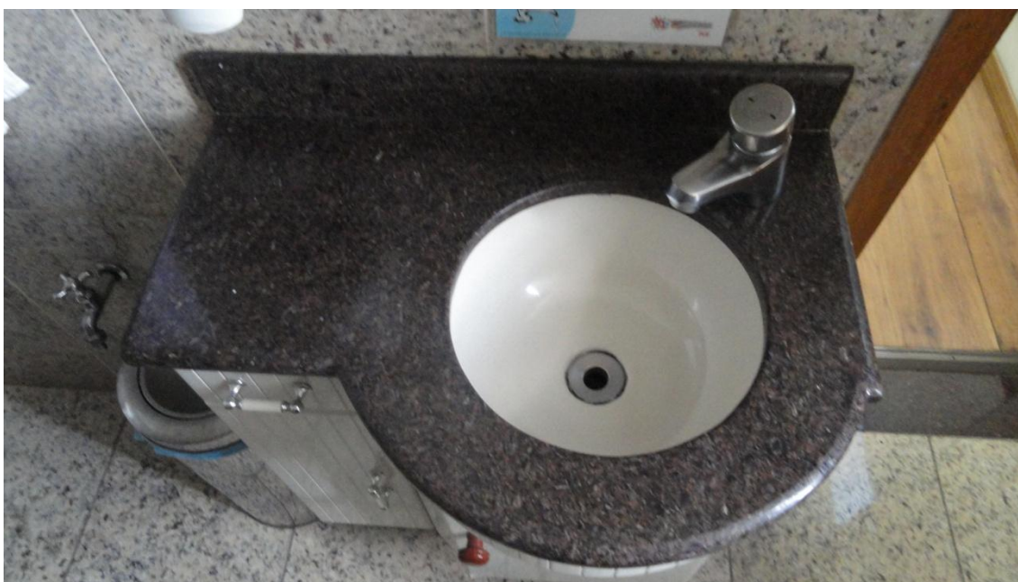
Foto 03 – Tampo do lavatório em granito café imperial, acabamento polido com bordas boleadas;
