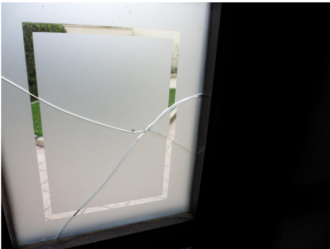
Foto 02 – Substituição de vidro quebrado na sala “G”.
