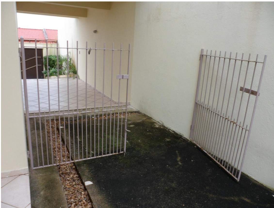
Foto 01 – Portão metálico a ser removido.
