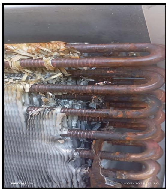
Figura 6 - Serpentina evaporador
