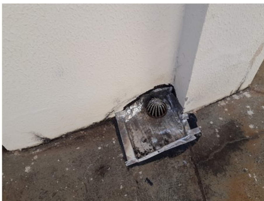
Foto 7 – Ponto de captação de água (registro em 23.3.22) associado à tubulação de drenagem da foto 6 – local: laje técnica com condensadoras do ar-condicionado.
