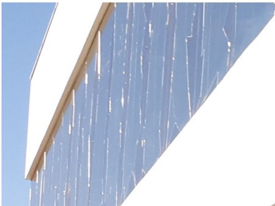
Foto 8 – Película de controle solar – fachada principal à rua Dr. Euclides da Cunha Viana
