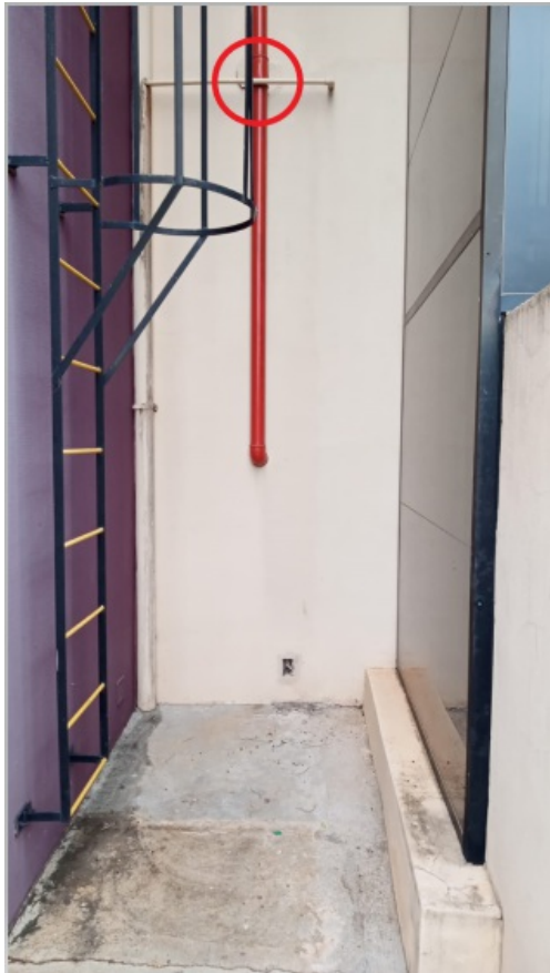
Imagem 1 - Tubulação a ser removida e local para tamponamento do ramal
