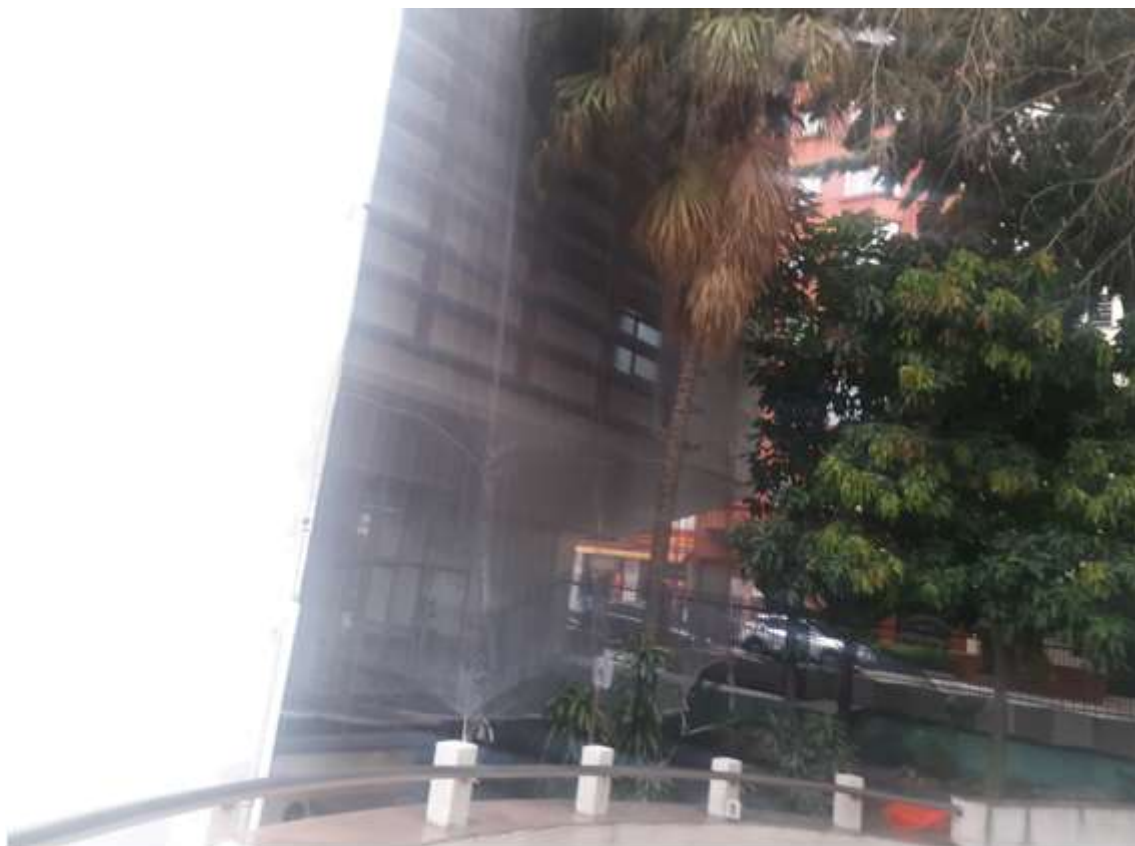
Foto 1 – Tela reinstalada em 7.11.2022
