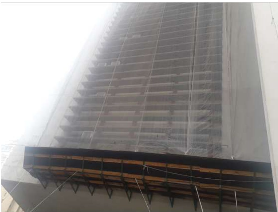
Foto 2 – Tela reinstalada em 7.11.2022.
