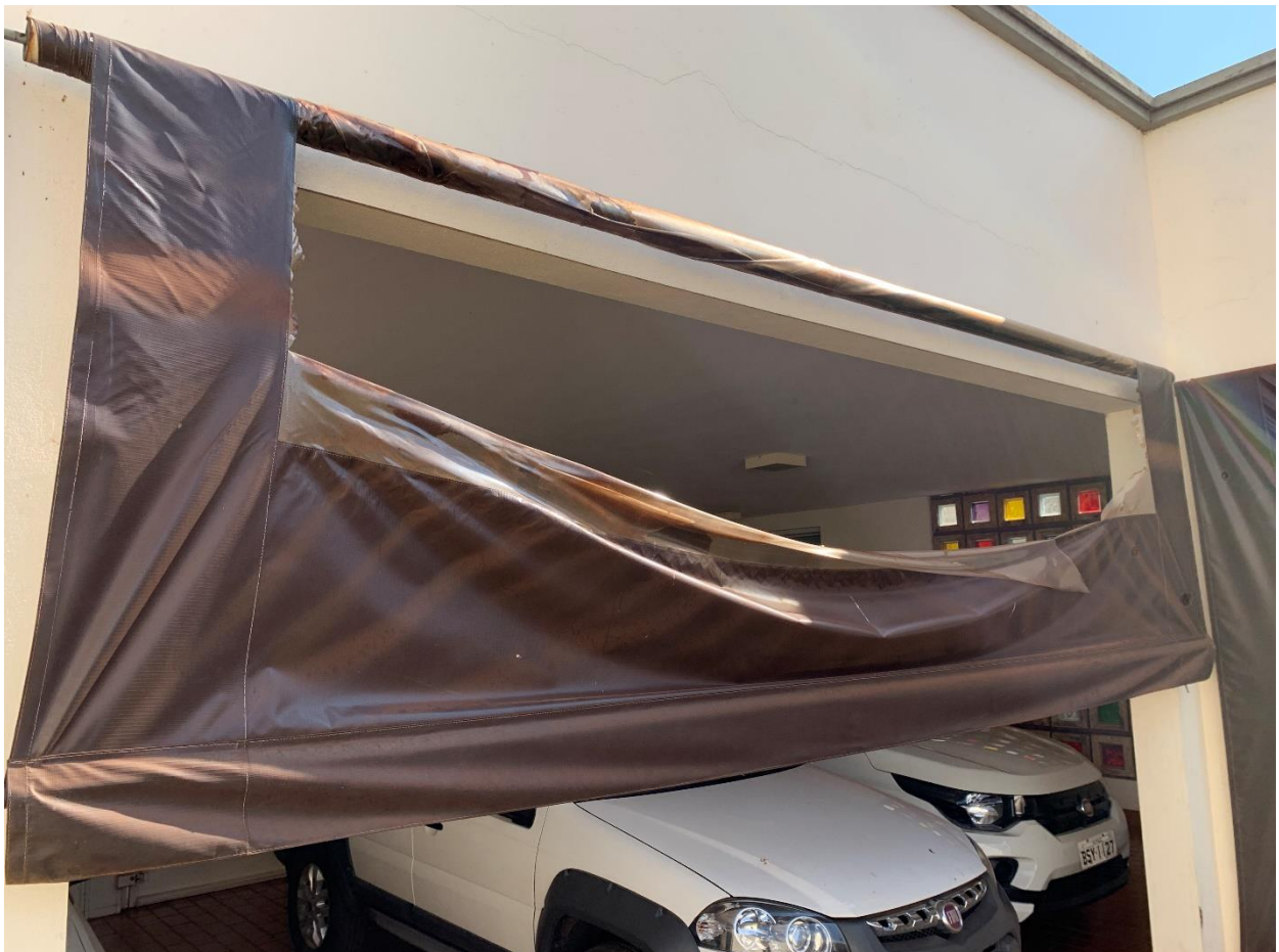
Visor rasgado. Não conseguimos nem abaixar o toldo mais do que está demonstrado na foto pois ele “travou” em virtude do visor danificado. Será feito no modelo só de lona, acima mencionado.
