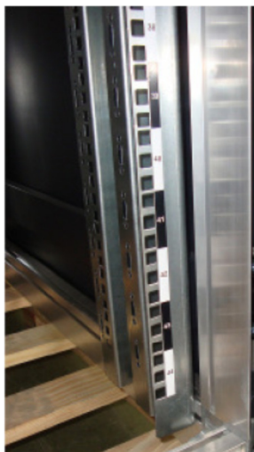
Vista frontal do perfil 19" Vista lateral do perfil 19"
