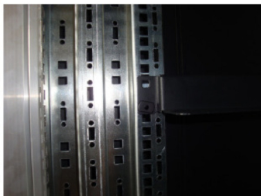
Vista frontal do perfil 19" Vista lateral do perfil 19"
