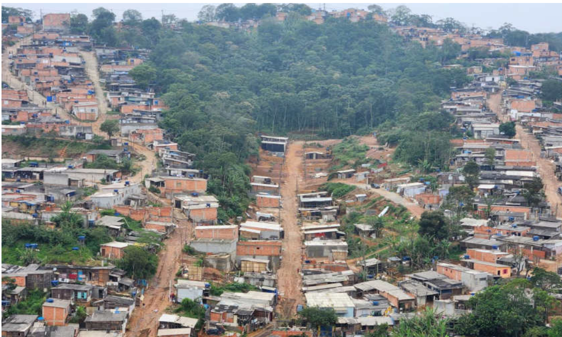
Figura 12 – Permanência das edificações em área de risco R4 no núcleo Toledanos
