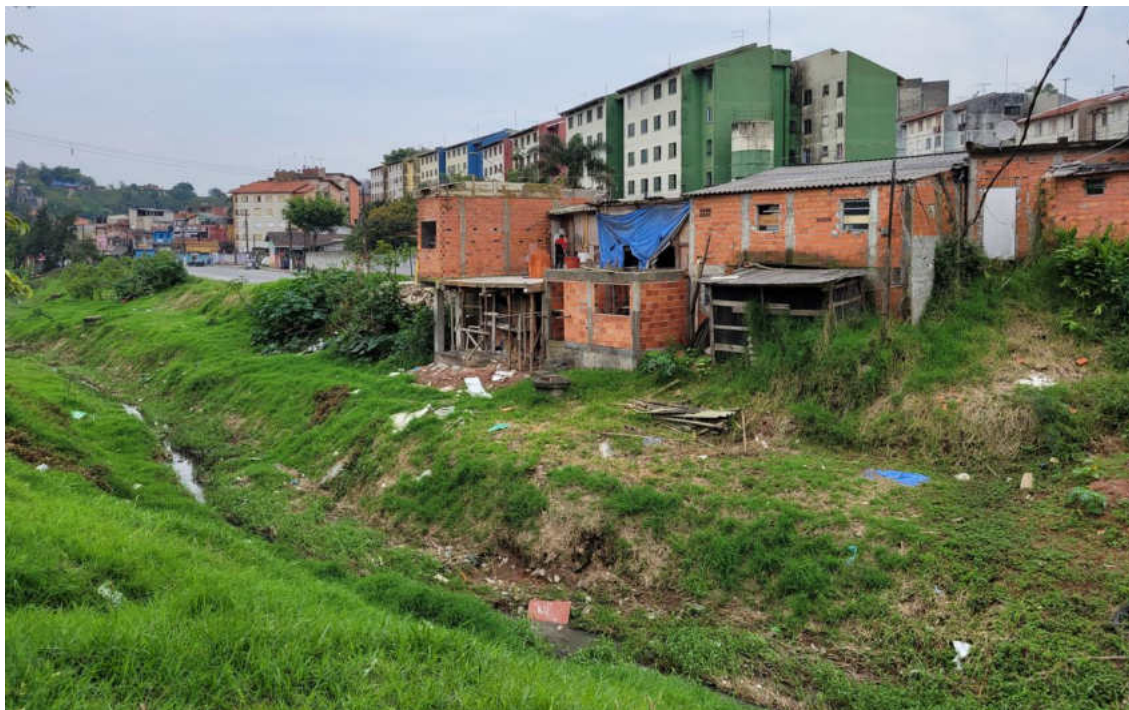
Figura 20 – Construções em áreas de risco hídrico no núcleo Dominicanos
