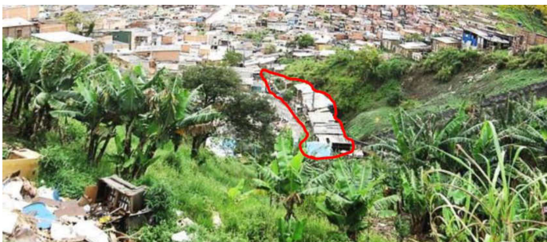
Figura 14 – Moradias precárias na base do talvegue no núcleo Toledanos em 2018
