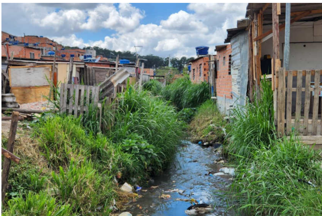
Figura 31 - Residências precárias sob risco de inundação na etapa 3 (1)
