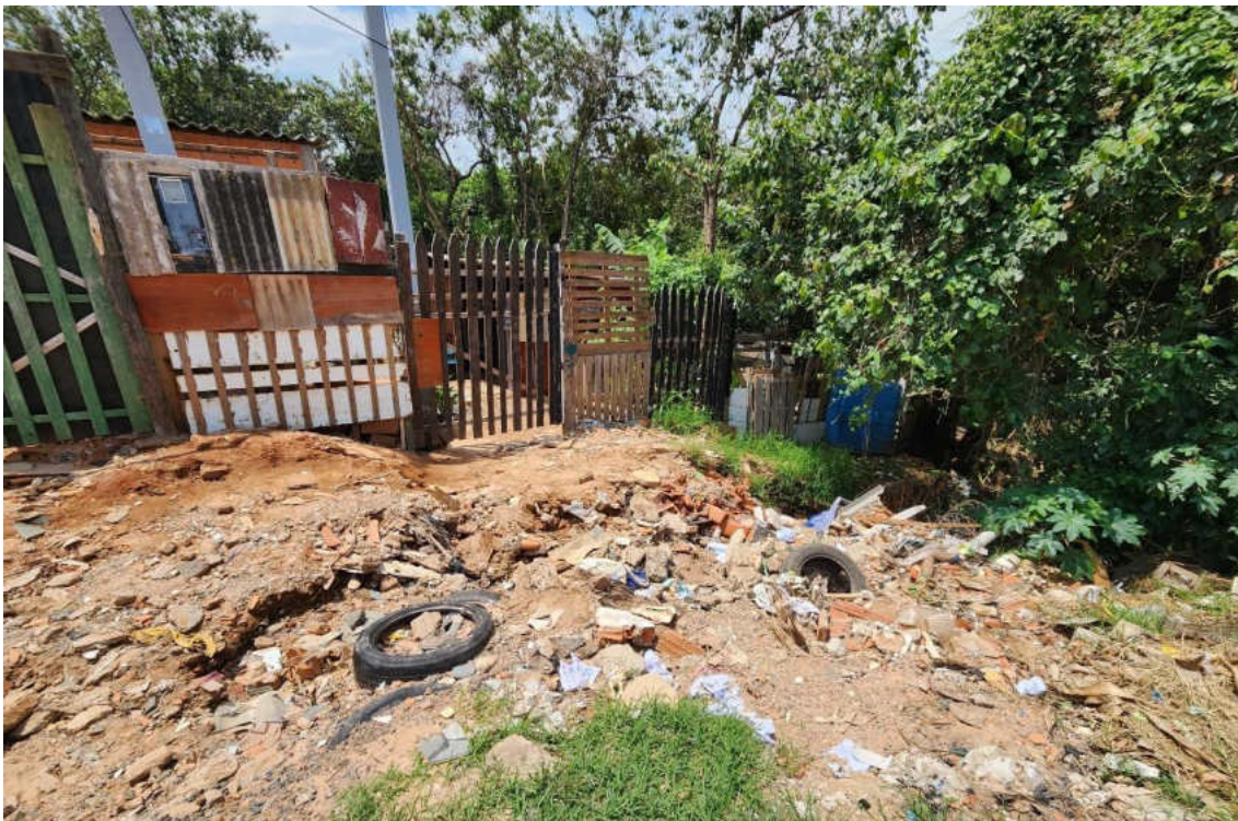
Figura 37 – Construções precárias próxima à margem de córrego em Hortolândia A3
