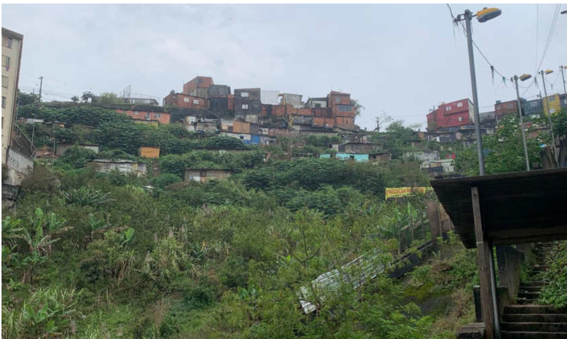
Figura 10 – Visão a partir das escadarias da reocupação em área de risco R4 no núcleo Lamartine
