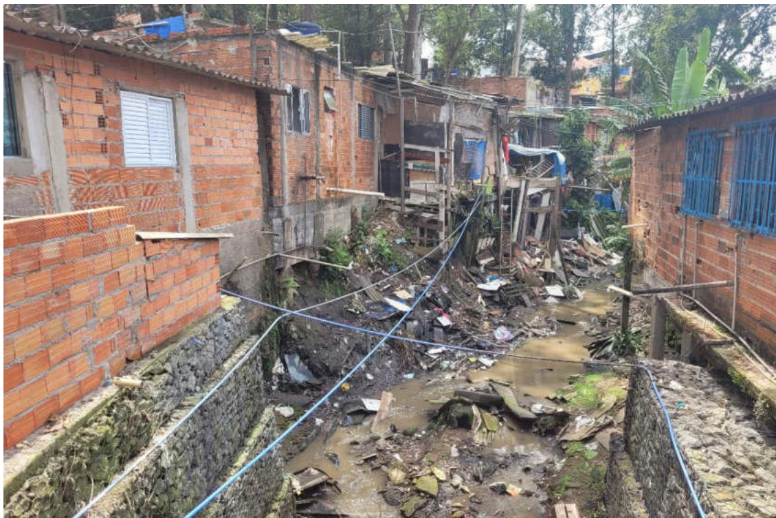
Figura 23 – Moradias precárias na margem do Córrego Taioca (1)
