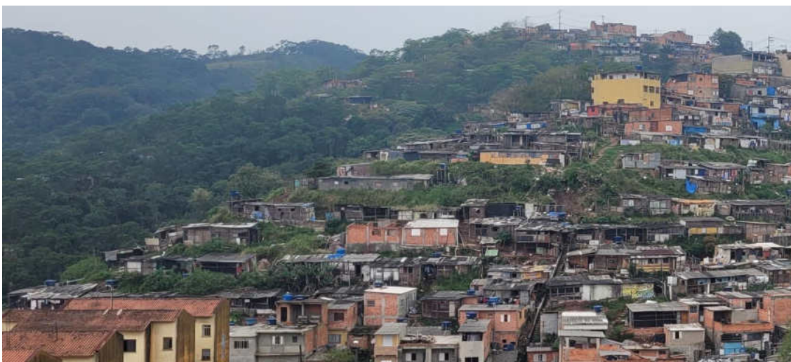
Figura 17 – Construções precárias em área de risco no núcleo Cruzado
