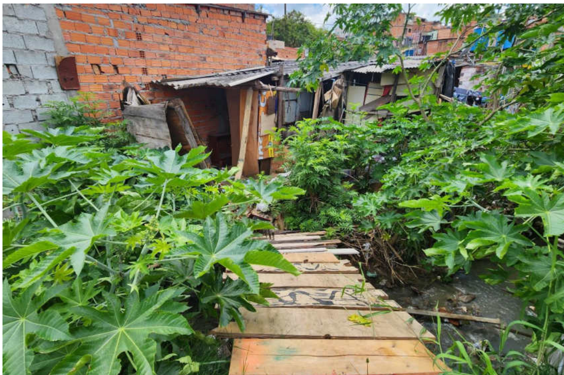
Figura 33 - Residências precárias sob risco de inundação na etapa 3 (3)
