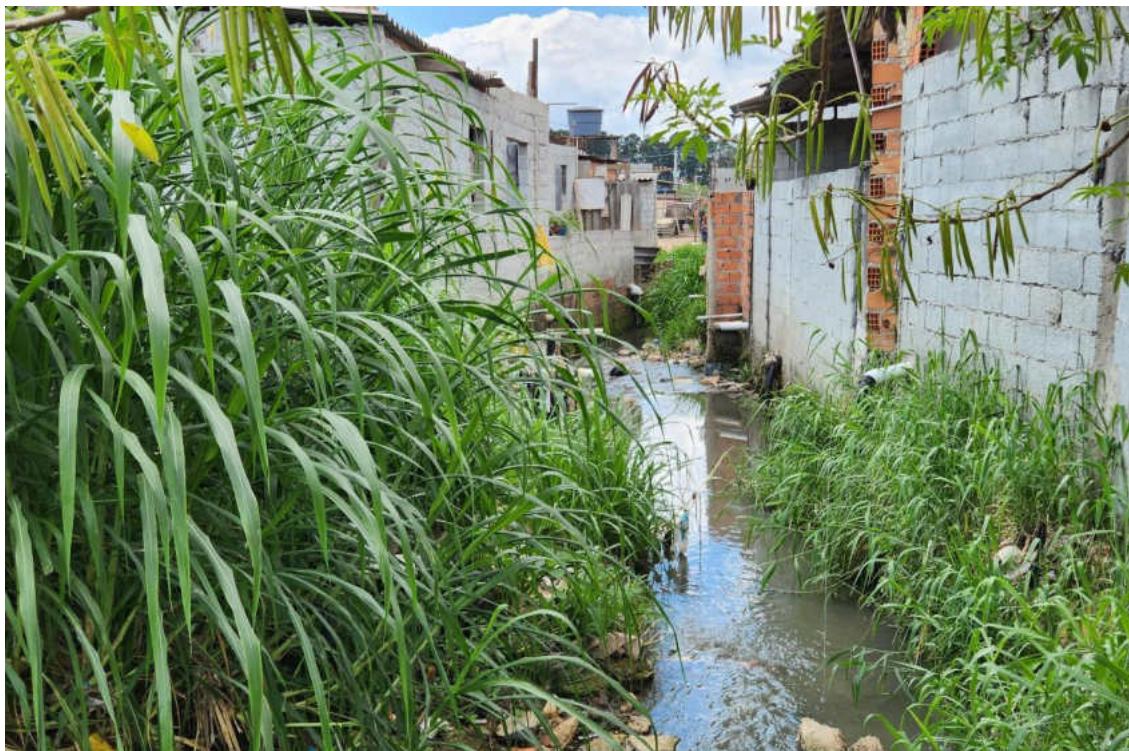
Figura 32 - Residências precárias sob risco de inundação na etapa 3 (2)
