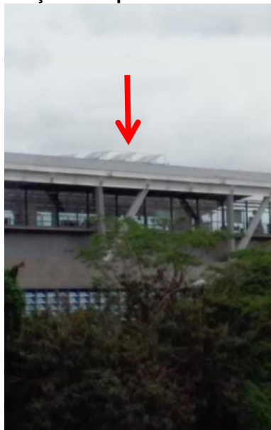
Painéis fotovoltaicos da estação Aeroporto-Guarulhos
