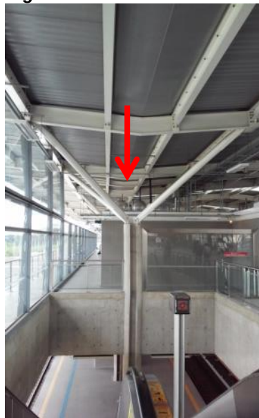
Reservatório de água aquecida por energia solar na estação Engenheiro Goulart
