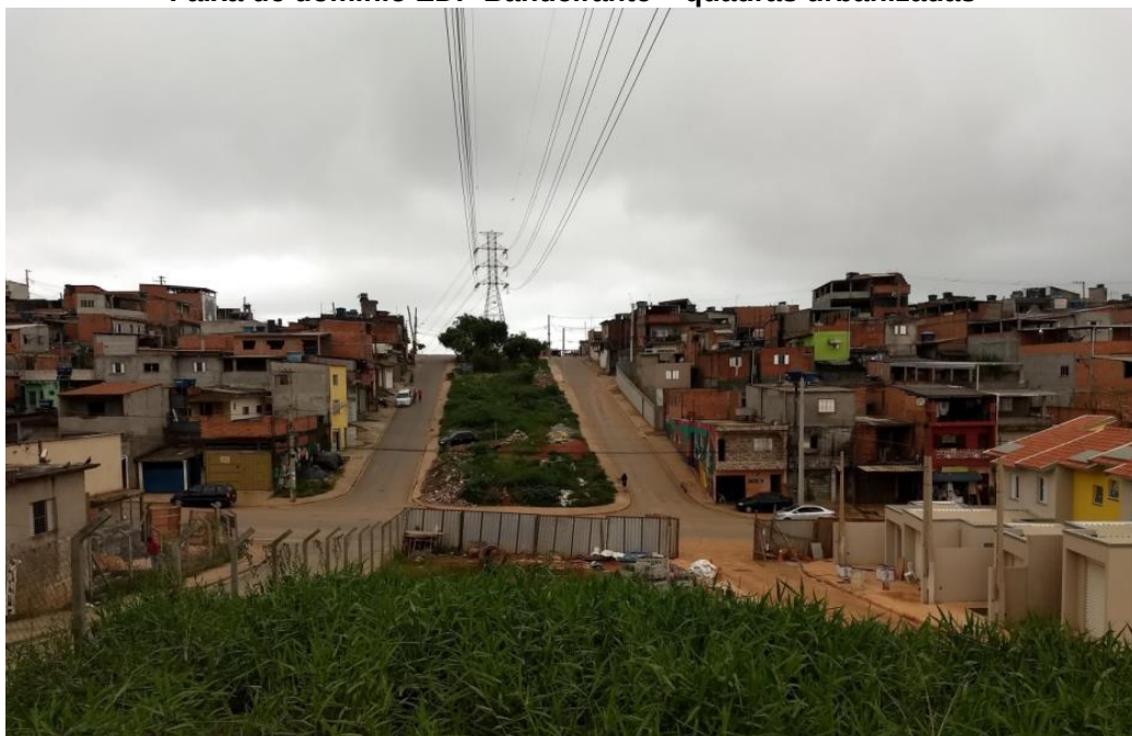
Faixa de domínio EDP Bandeirante – quadras urbanizadas
