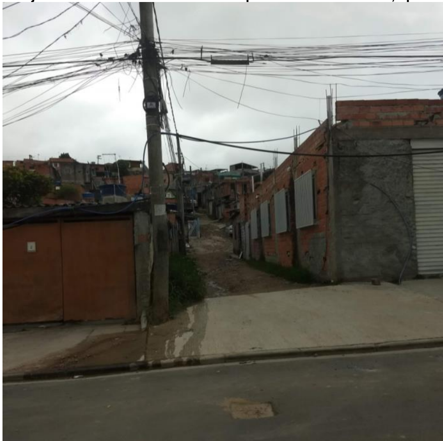
Viela Projetada 14 - área removida do escopo do contrato 53/2013, após aditivo
