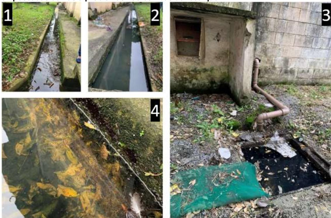
Legenda: Fotografias 1, 2 e 4: canaletas com água empossada. Fotografia 3: poço de água pluvial onde ficava uma das bombas de recalque queimadas.
