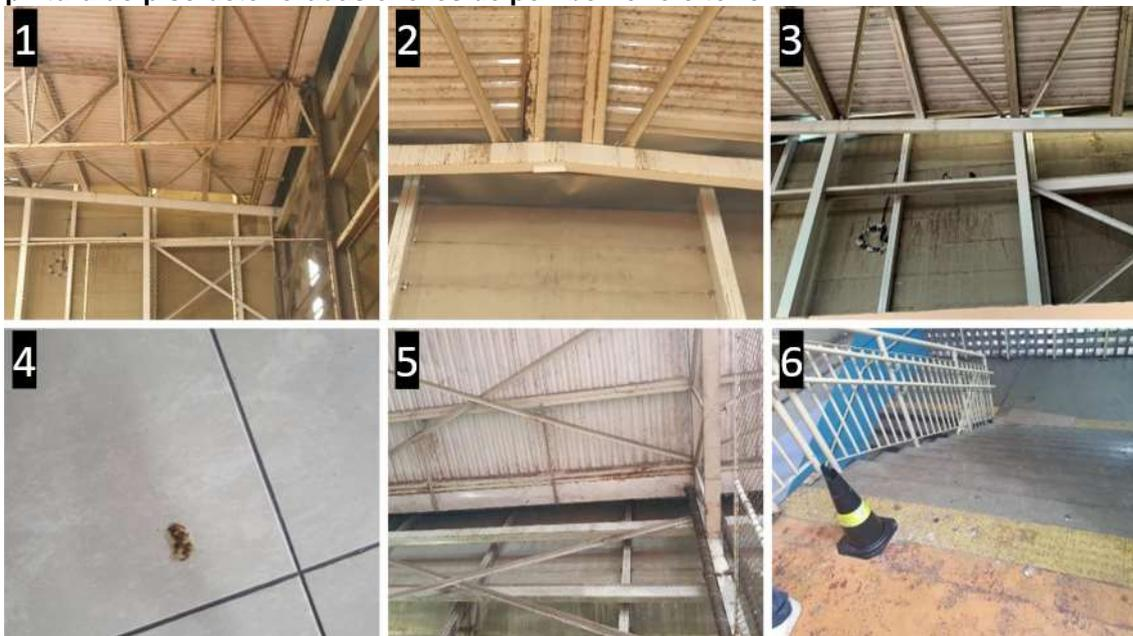
Legenda: Fotografias 1 e 3: pombos na quadra; Fotografias 2 e 5: estrutura metálica deteriorada. Fotografia 4: fezes de pombo no refeitório. Fotografia 6: a pintura do piso deterioradas e com fezes de pombo.
