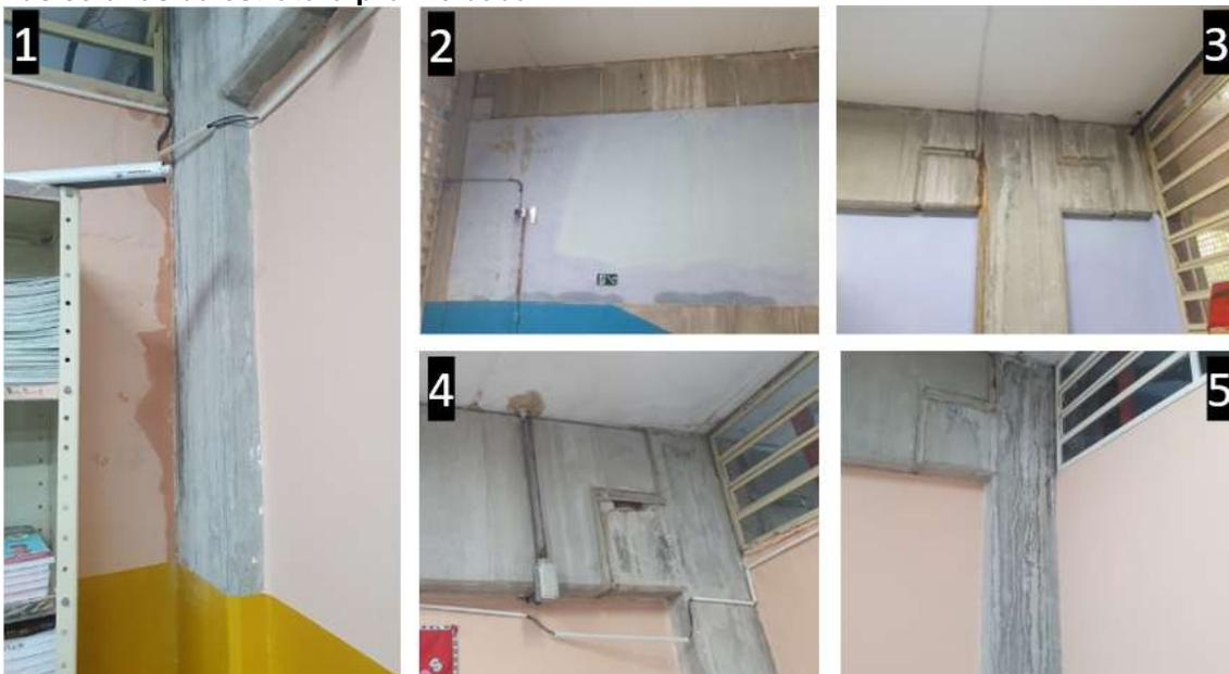
Legenda: Fotografia 1: parede de sala de aula úmida por vazamento. Fotografia 2: parede da escada úmida e coluna da estrutura pré-moldada com marcas de vazamento. Fotografias 3, 4 e 5: marcas de vazamento em colunas da estrutura pré-moldada em salas de aula.
