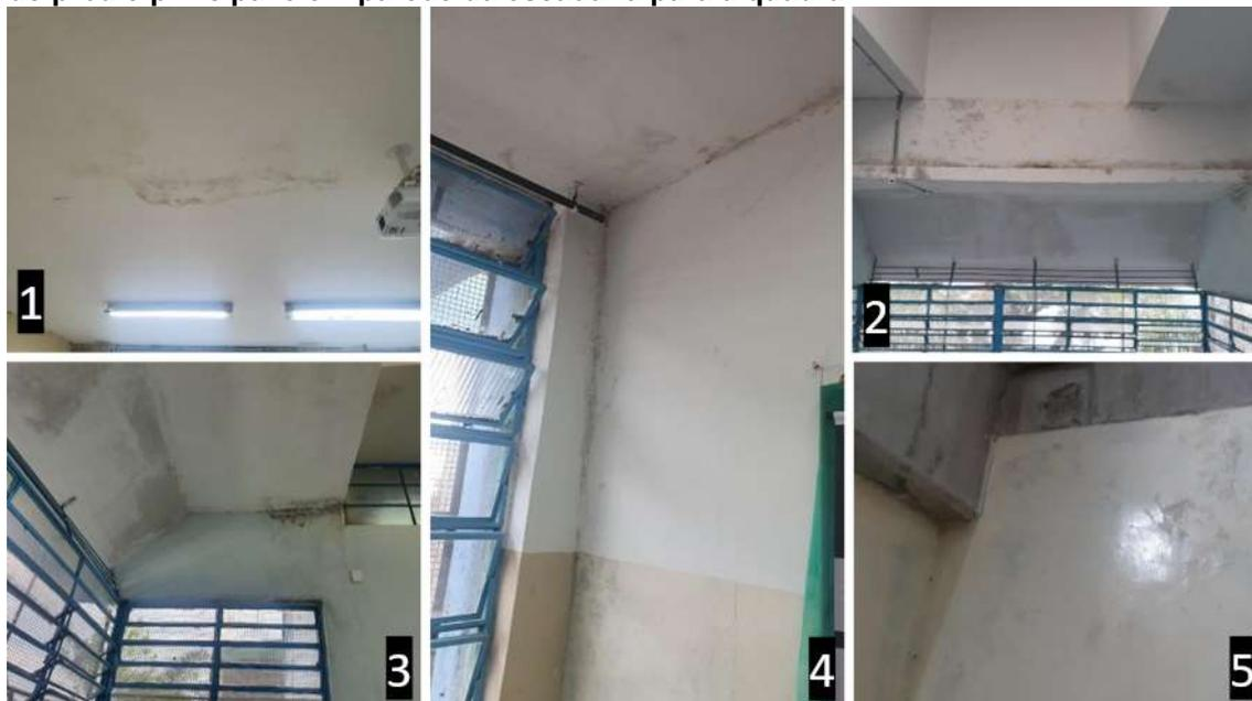
Legenda: Fotografia 1: marca de vazamento não restaurada na sala de informática. Fotografias 2, 3 e 4: marcas de infiltração e vazamento não restauradas em tetos e paredes nas escadarias do prédio principal. Fotografia 5: marcas de infiltração em paredes da escadaria para a quadra no prédio contíguo.
