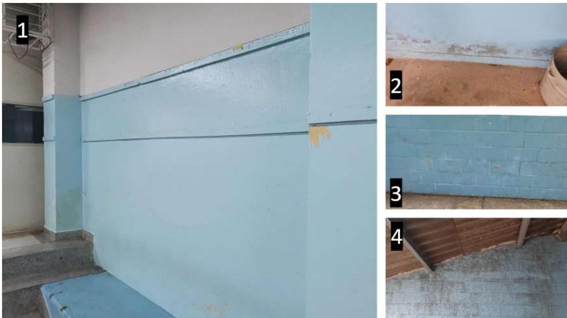
Legenda: Fotografia 1: tinta descascando e manchas na pintura em parede do pátio. Fotografia 2: parede da entrada da secretaria com tinta esfarelando por infiltração. Fotografia 3: mureta próxima a quadra com tinta esfarelando por infiltração. Fotografia 4: parede da entrada da secretaria pintadas sobre sujeira e infiltração.
