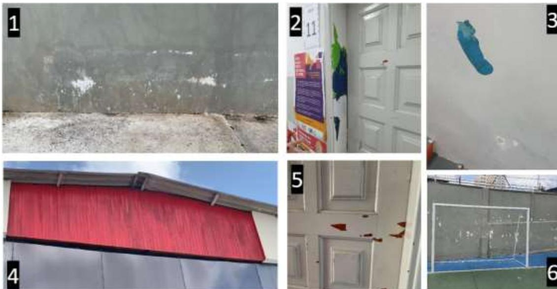
Legenda: Fotografia 1: tinta da face externa do muro de divisa com tinta esfarelado por umidade. Fotografias 2 e 5: pintura das portas e batentes descamando. Fotografia 3: tinta descascando, esfarelado e com marca de infiltração no barrado da escadaria do pavimento inferior. Fotografia 4: pintura do fechamento frontal da cobertura manchada devido à aplicação de tinta sobre sujeira antiga. Fotografia 6: tinta da face interna do muro de divisa com tinta descascando.
