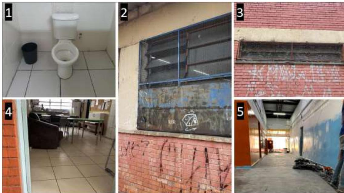
Legenda: Fotografia 1: vaso sanitário do banheiro acessível sem barras de apoio. Fotografia 2 e 3: fachadas sujas, não realizada limpeza por hidrojateamento. Fotografia 4: piso da sala de coordenação antigo, não substituído. Fotografia 5: circulação do bloco 1 com piso antigo, não substituído.
