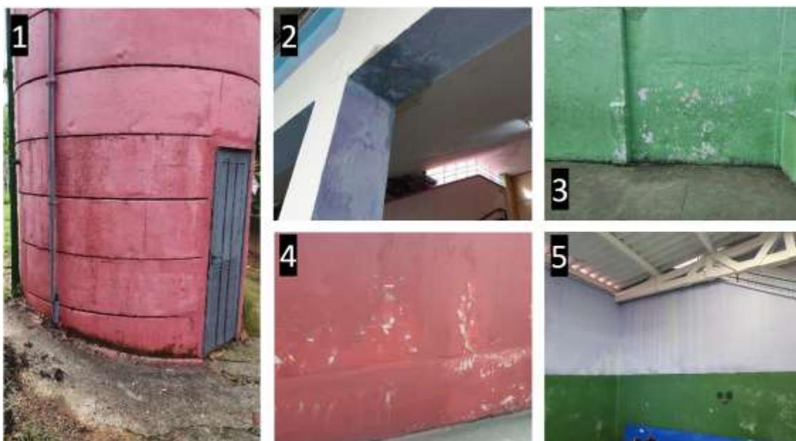
Legenda: Fotografia 1: pintura do reservatório desbotando. Fotografia 2: pintura desbotando e marca de infiltração em coluna entre pátio e passagem entre blocos. Fotografias 3 e 4: pinturas externas do pátio desmanchando. Fotografia 5: coluna na circulação com mofo. Fotografia 5: pintura do ateliê desbotando por conta de vazamento.
