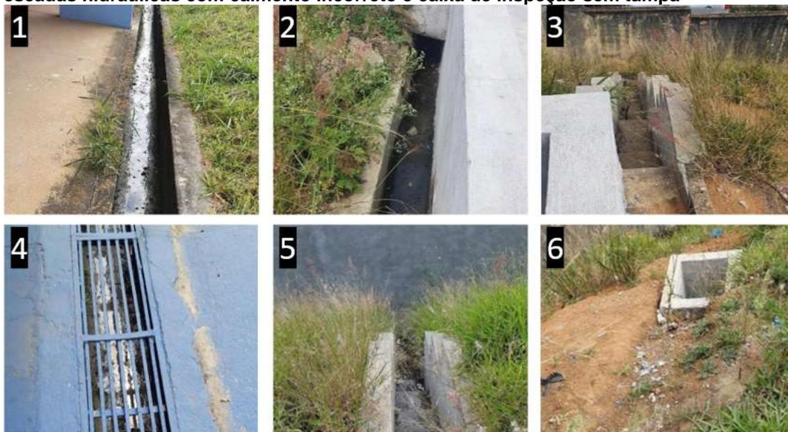
Legenda: Fotografias 1, 2 e 4: canaletas com água empossada. Fotografia 3: escada hidráulica inadequada, seca, em ponto mais alto da canaleta. Fotografia 5: escada hidráulica adequada, molhada. Fotografia 6: caixa de inspeção sem tampa.
