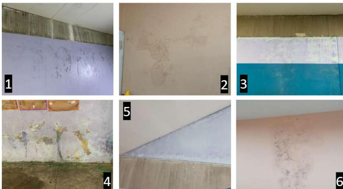
Legenda: Fotografia 1: marcas de infiltração na parede da escadaria. Fotografias 2 e 6: marcas de infiltração e mofo na sala de materiais esportivos. Fotografias 3 e 5: pintura desbotando por conta de vazamento. Fotografia 4: massa niveladora se desfazendo e revelando camadas antigas de tinta.
