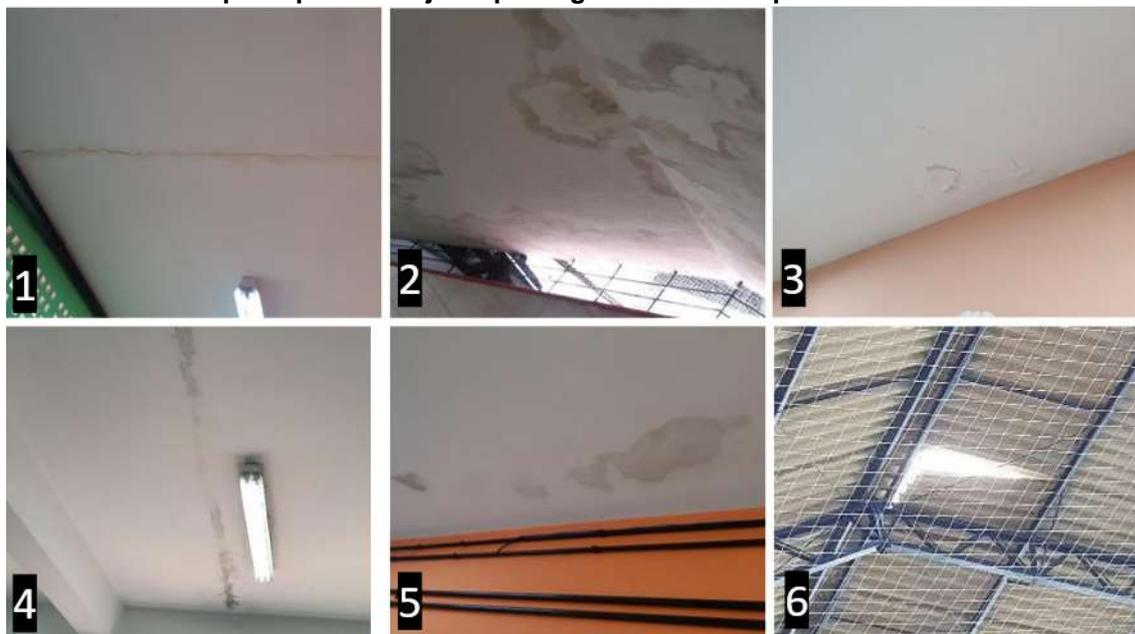
Legenda: Fotografias 1,3, 4 e 5: marcas de vazamento em tetos de circulações. Fotografia 2: marcas de infiltração e vazamento na laje de passagem. Fotografia 6: telha mal fixada na quadra e deslocada.
