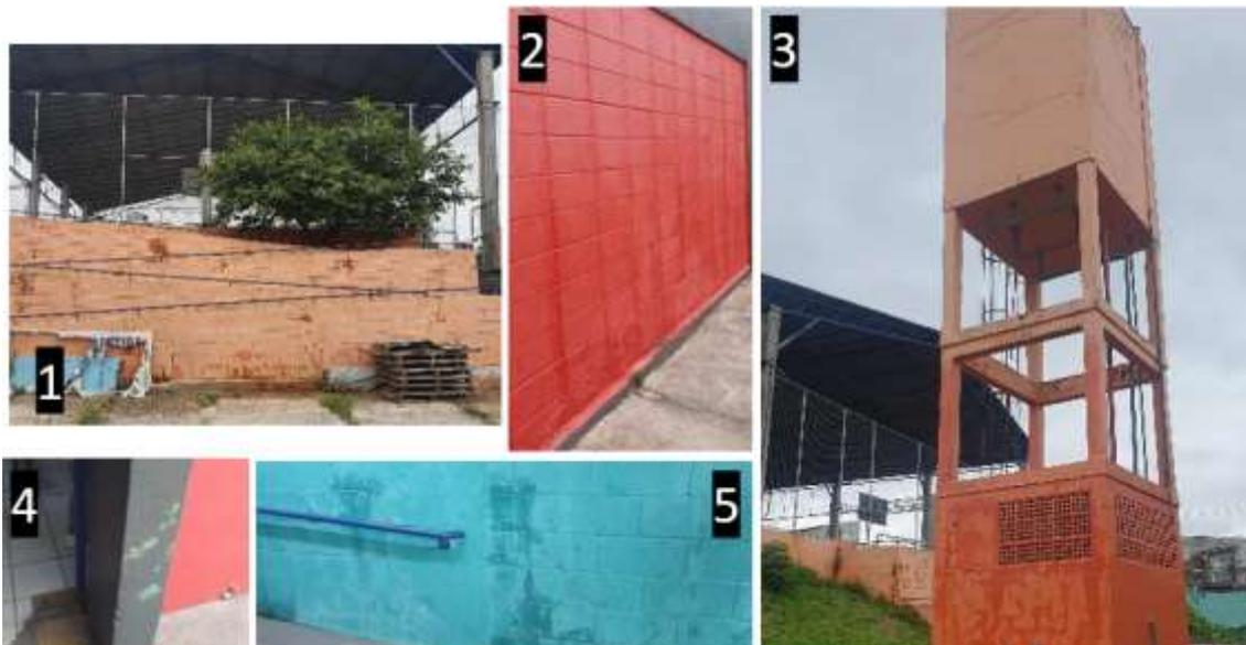
Legenda: Fotografia 1: muro da quadra com pintura desbotada. Fotografia 2: manchas na pintura de parede do bloco superior por conta da aplicação de resina sobre a tinta. Fotografia 3: reservatório com tonalidades diferentes e parte inferior manchada devido à aplicação de resina. Fotografia 4: coluna do bloco superior com tinta descascando. Fotografia 5: rampa de acesso ao bloco superior com manchas por conta de infiltração.
