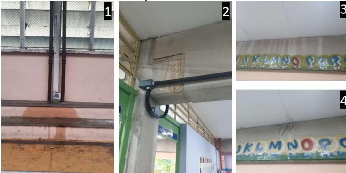
Legenda: Fotografia 1: vazamento na calha do telhado da quadra. Fotografia 2: marcas de vazamento em coluna da estrutura pré-moldada na circulação. Fotografias 3 e 4: marcas de vazamento em colunas da estrutura pré-moldada em salas de aula.
