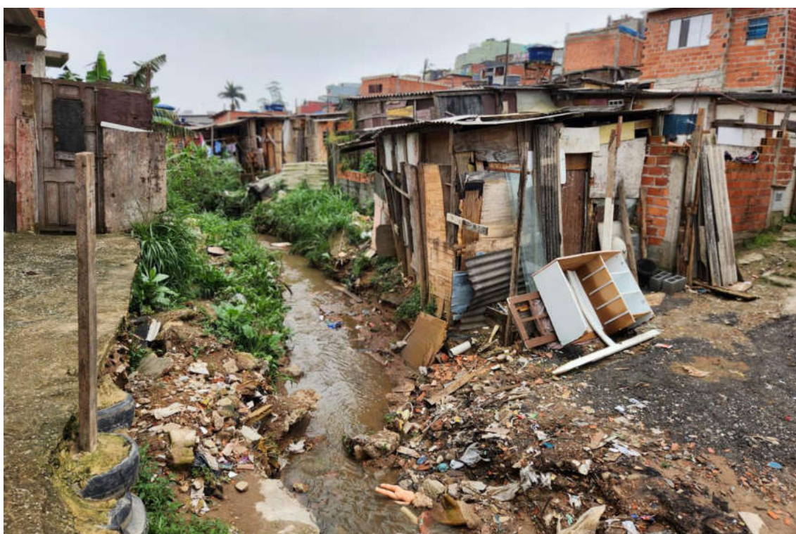
Figura 18 – Construções de madeira em áreas de risco hídrico entre os núcleos Toledanos e Missionários
