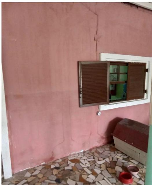
**Fotografia 8 – Parede com rachaduras e mofo na CT República da Vida - Prevenção e Auxílio Comunitário ao Toxicômano**
