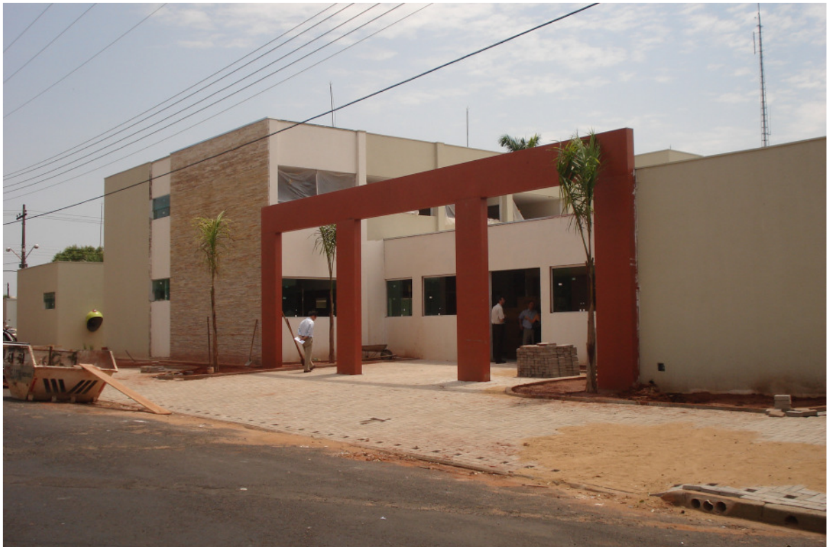
VOTUPORANGA/SP FUTURAS INSTALAÇÕES DO AMBULATÓRIO MÉDICO DE ESPECIALIDADES - AME
