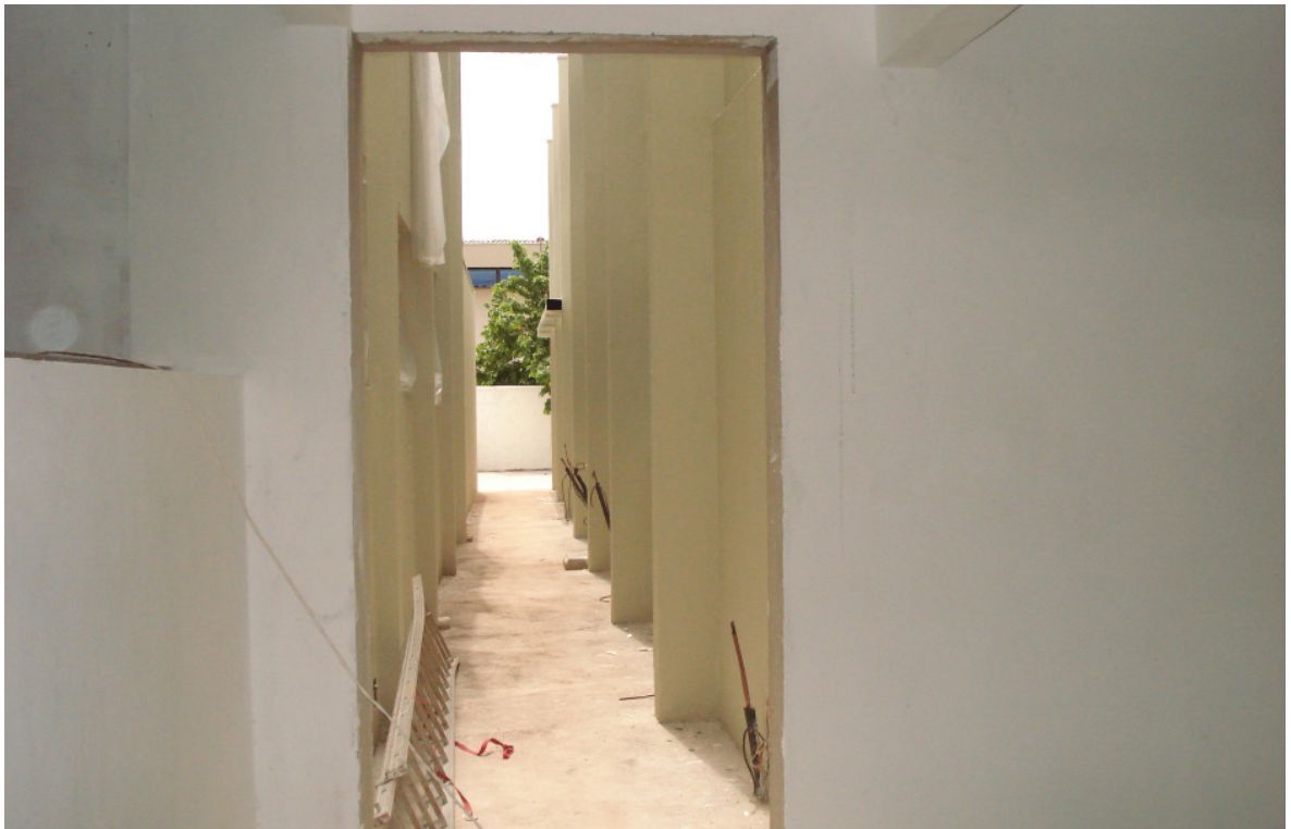
VOTUPORANGA/SP FUTURAS INSTALAÇÕES DO AMBULATÓRIO MÉDICO DE ESPECIALIDADES - AME
